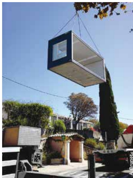
Arrivée d'une des trois parties de l'algeco, à l'école maternelle.
