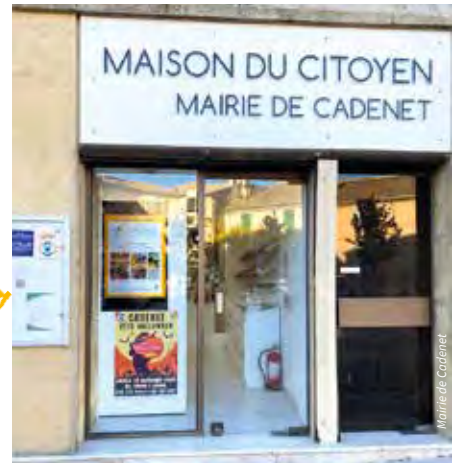
La Maison du Citoyen, place du Tambour d'Arcole.
