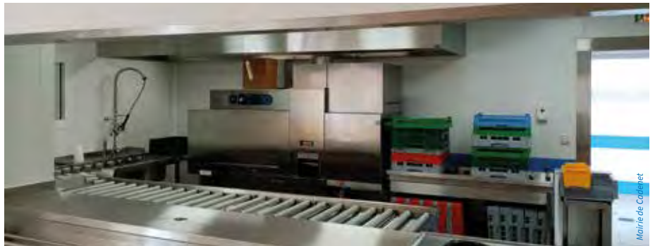
Première phase des travaux de rénovation de la cantine.
